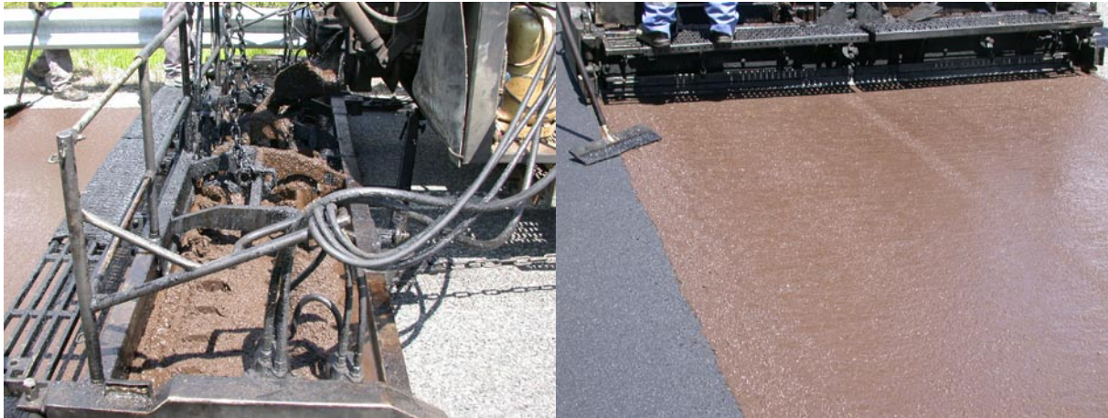
photo 6 : vue du chariot et de la vis de répartition sur une machine à ECF (Jean-Pierre Henrat - COLAS).
