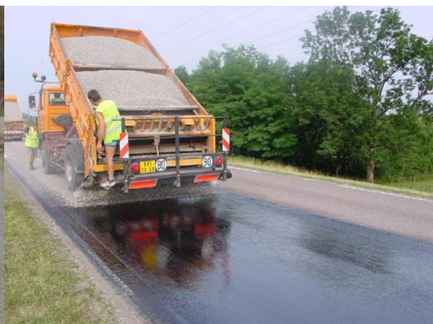
photo 2 : répandage du gravillon faisant suite à l'épandage du liant (Jean-Claude Menard - LRPC Autun).
