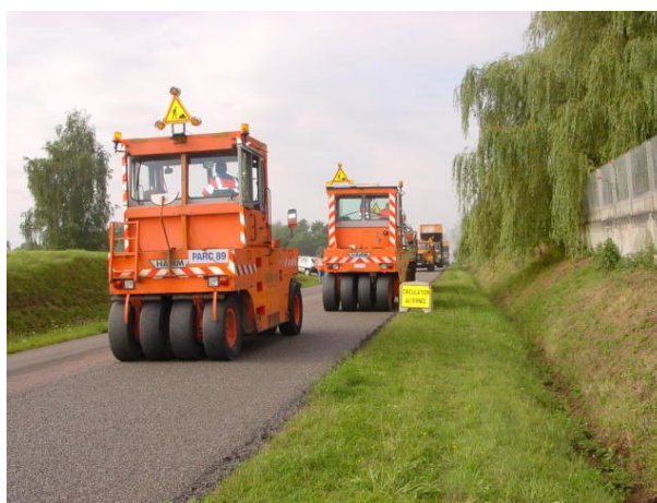
photo 5 : mise en place de la mosaïque par compactage de l'ESU (Jean-Claude Menard - LRPC Autun).
